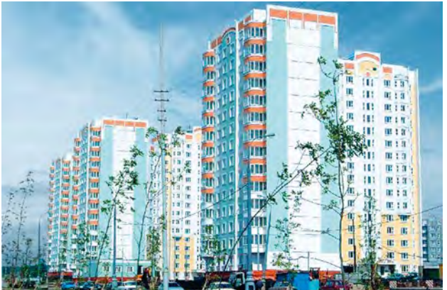
Abb. 6_Renovierte Plattenbauten nach dem «Moskauer Pass»
